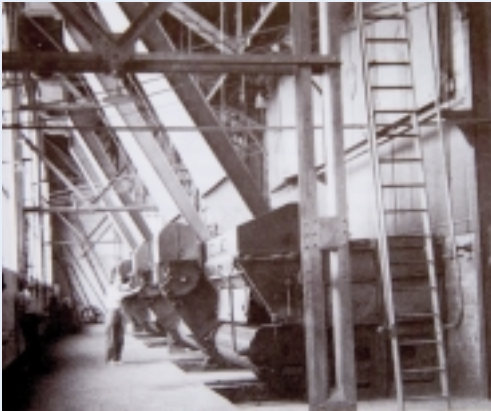
Sala de calderas (1946)
